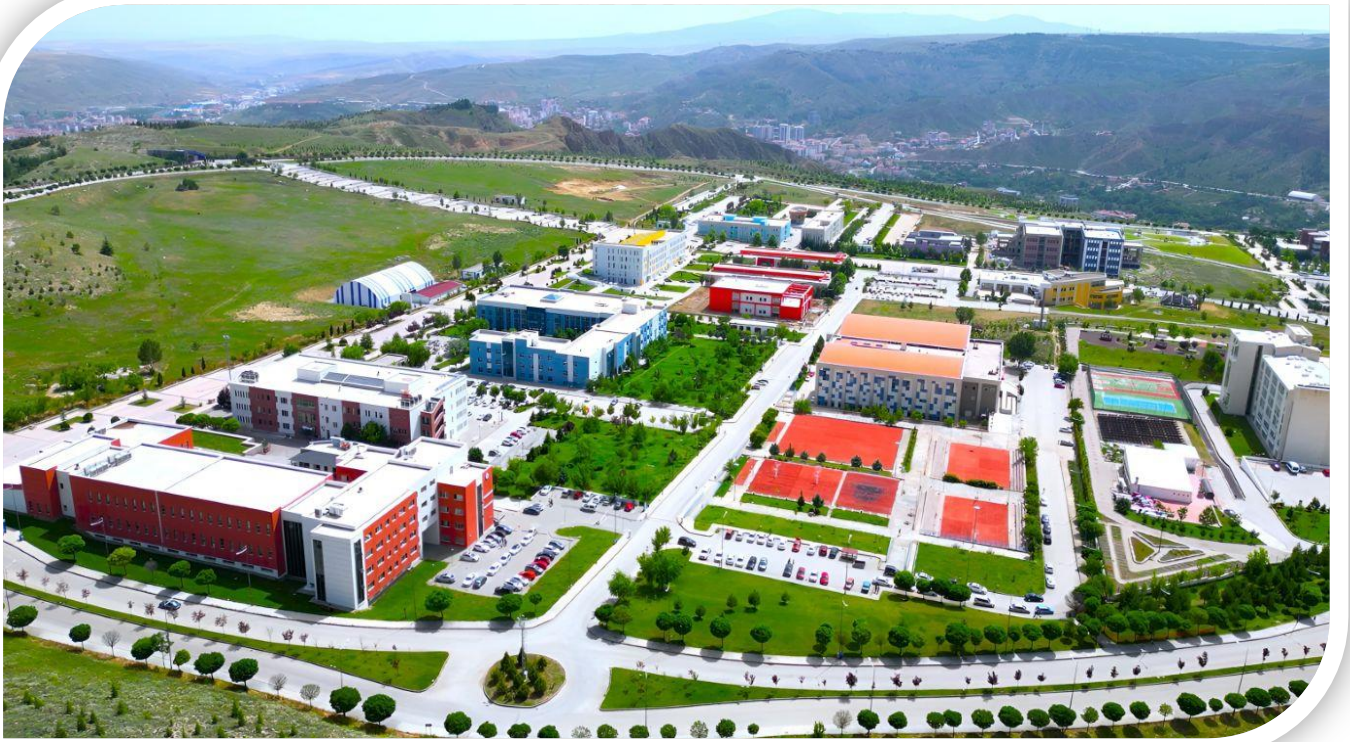
Şekil 1. Uluyazı Yerleşkesinden Bir Kesit.
