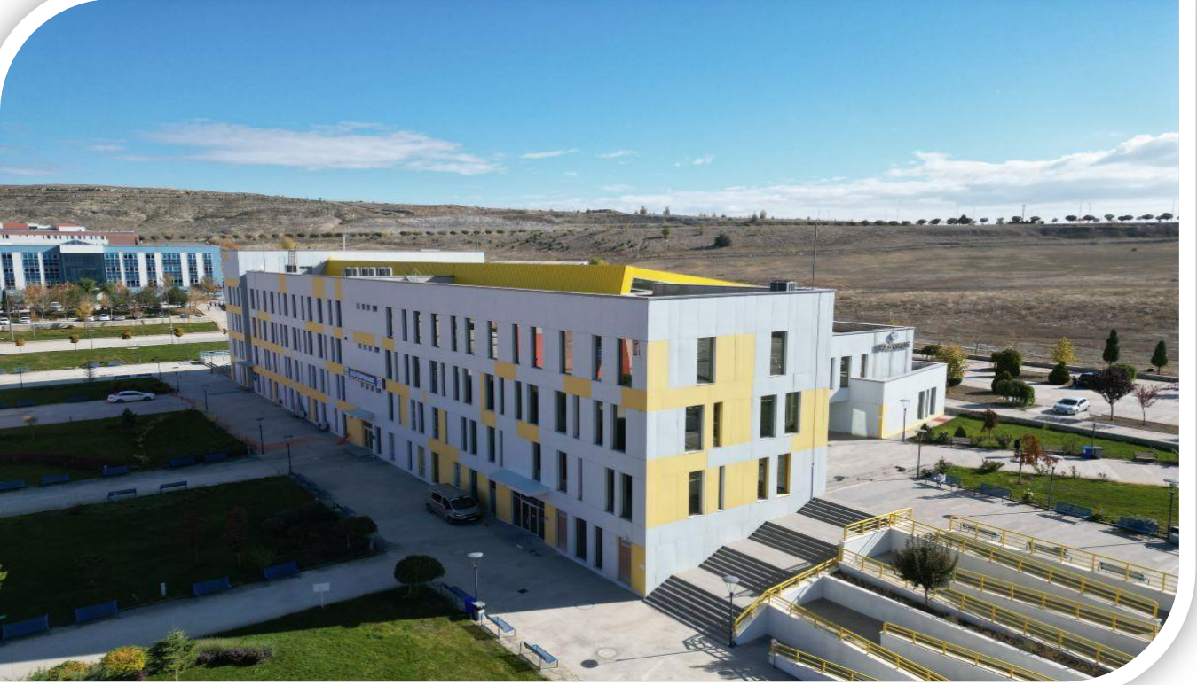
Şekil 7. Üniversitemiz Kütüphane Binasından Bir Kesit.
